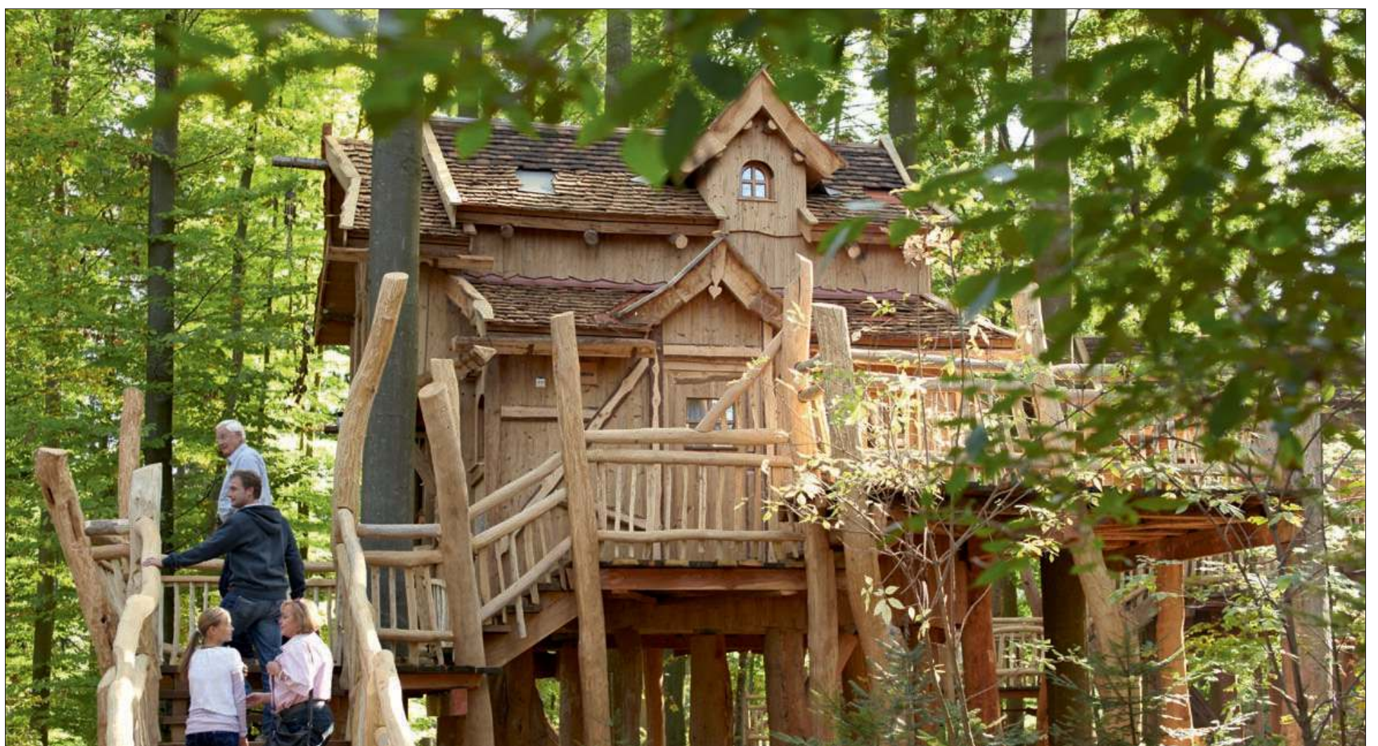
Wie kleine Wichtelhäuschen sehen die neuen Baumhäuser in Tripsdrill aus. Sie stehen auf Stelzen mitten im Wald
